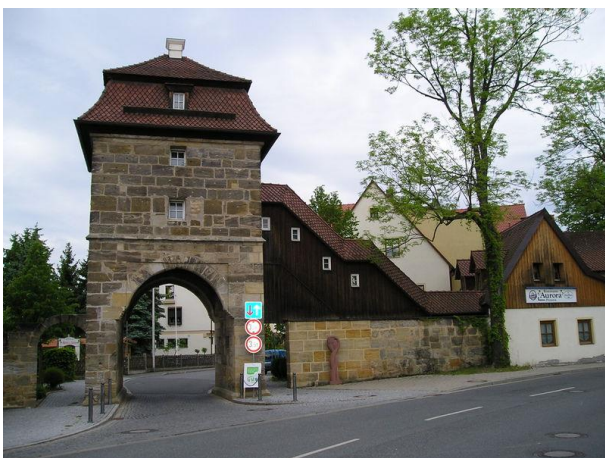
Bild 3: Foto Erlanger Tor zul. LH=3,2m, einstreifig
