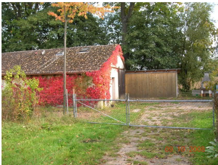
Bild 7 – Gebäude auf Fl.-Nr. 417
