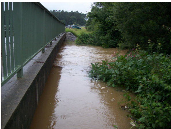
Abb. 3 : Abfluss an der St2243 am 20.07.2011
