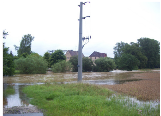
Abb. 4: Überschwemmung an der Habernhofer Mühle am 20.07.2011
